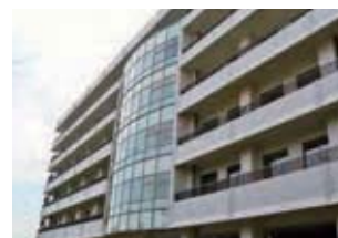
新病棟外観(北側)
