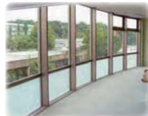
工が進む新病棟内(ディールーム)
