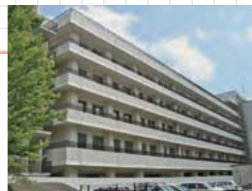
外観が現れた新病棟
