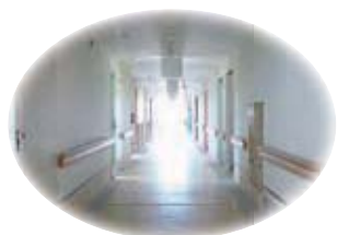
工が進む新病棟内(廊下)
